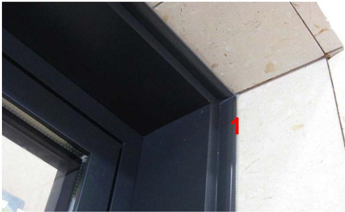
3. Una vez colocada carpintería exterior se realiza un segundo sellado entre esta y el acabado de la fachada.
